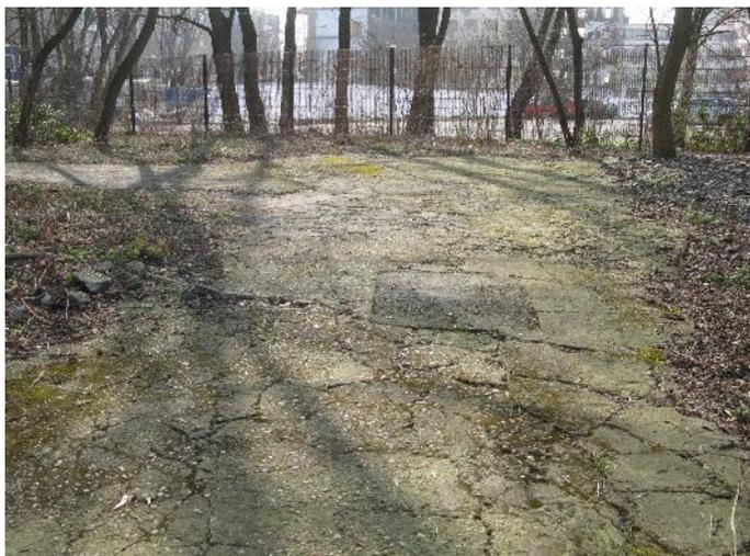
Wurzelaufbrüche, beschädigte Asphaltdecken
